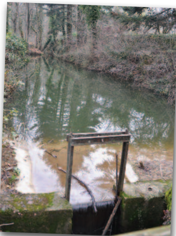
Curage étang des Pêcheurs et remise en état source du lac
