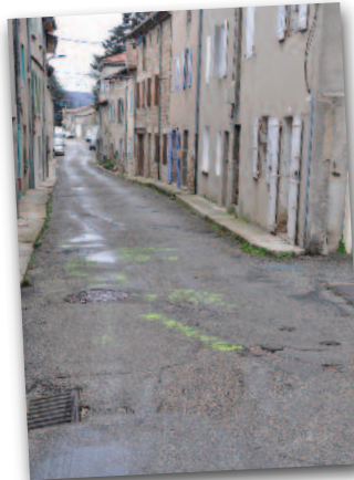
Sécurisation accès rue Antonin Calixte au passage du Cheminou avec barrières rouges
