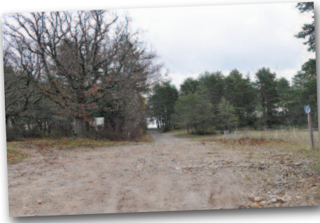
Enfouissement ligne les Pêcheurs - Bois du Four
