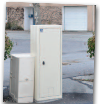
Création d'une borne foraine place de la Gare
