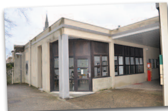
Etanchéité toit local « Le Cheminou »
