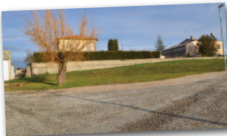
Chemin de Fleureton (terrassement Malterie)
