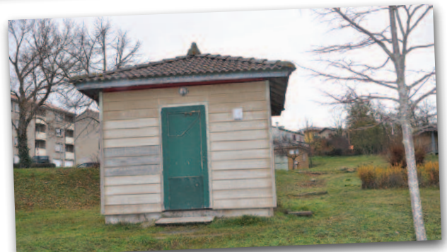
Création toilettes publiques, parking des gîtes du lac côté zone artisanale
