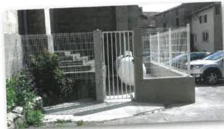
Sécurisation de la cuve de gaz derrière l'Eglise
