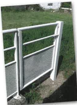
Installation d'un portillon pour l'accès aux Jardins partagés
