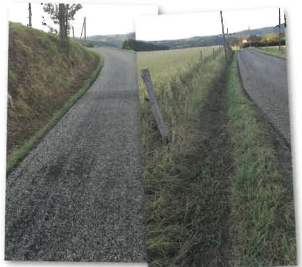
Fossés creusés au niveau de la route en direction de Savinas sur environ 6km, pour évacuer de manière efficace l'eau de pluie, et aménagement de la voirie
