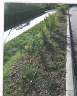
Installation d'un arrosage automatique des espaces verts Avenue de Baschi
