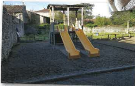
Réfection du sol du toboggan à l'école maternelle
