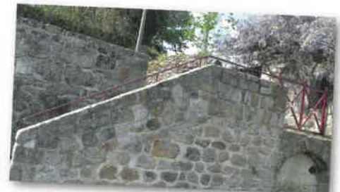
Pose d'une main courante aux escaliers du Cheminou
