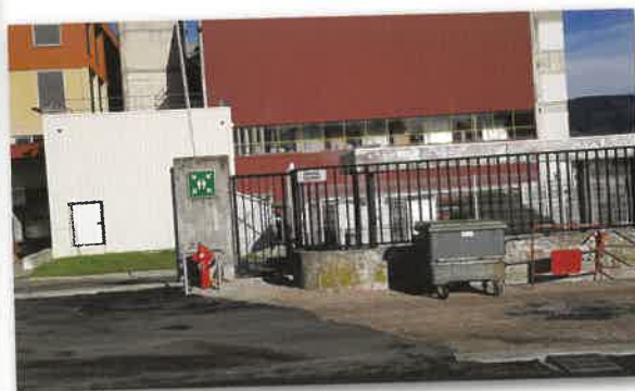
Création borne incendie RD21
