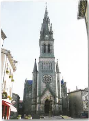
Remise en conformité du clocher de l'Eglise
