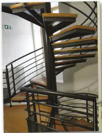
Escalier de secours
