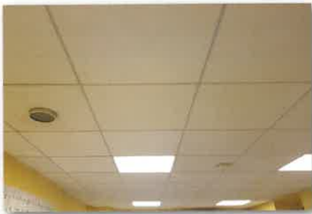
Plafond de l'école élémentaire
