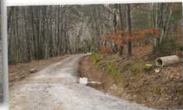
Fossé et passage de buse au Serpoulet
