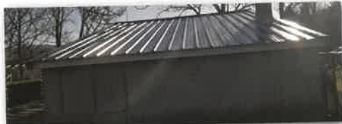
Réfection de la toiture du snack
