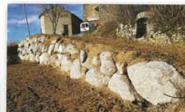
Enrochement chemin de Terras
