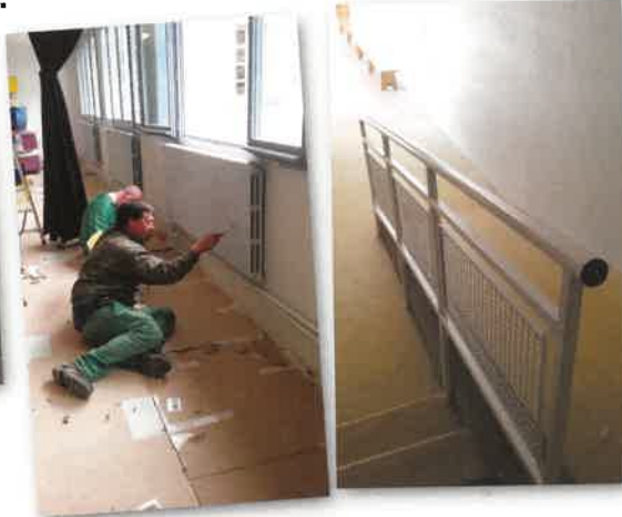
Réfection de la salle de motricité de l'école maternelle
