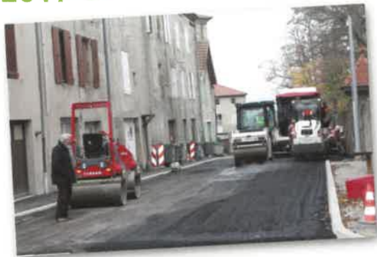
Travaux de voirie
