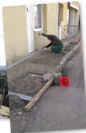
Travaux de voirie village
