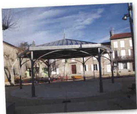
Installation d'un kiosque
