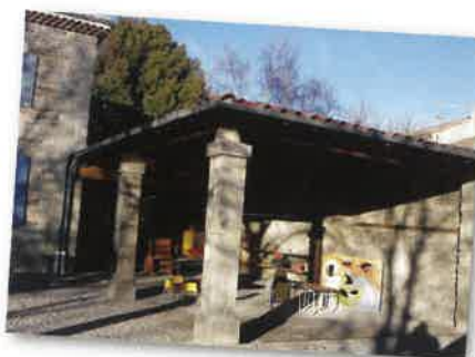
Réfection du préau de l'école maternelle
