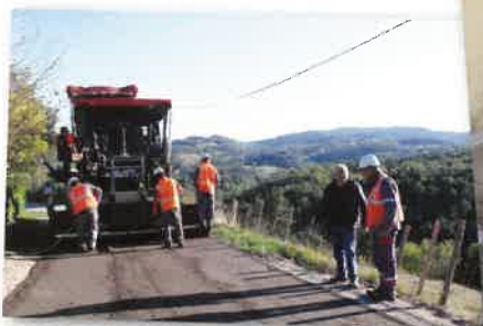
Travaux de voirie
