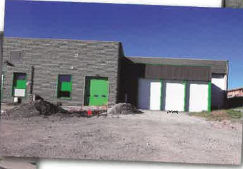
Aménagement extérieur et intérieur du nouveau local du service technique
