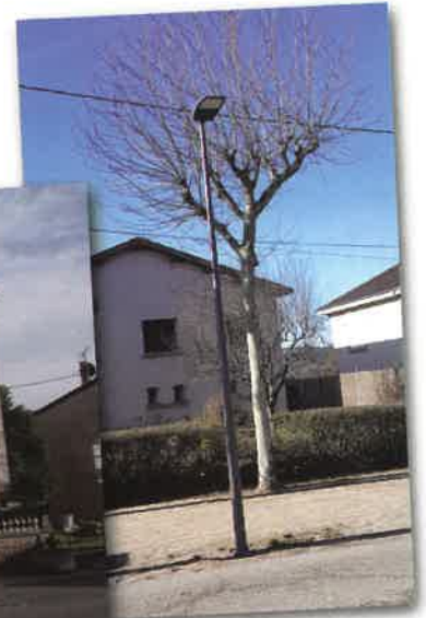
Deuxième tranche pour le remplacement de l'éclairage public LED du village
